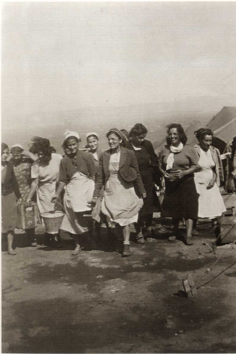
Προσωρινή εγκατάσταση, Μακρόνησος 1950.
